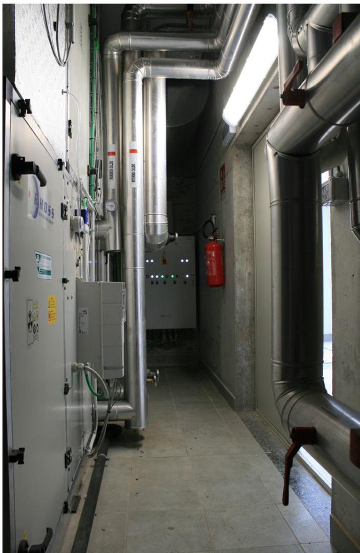
Al piano superiore della torre tecnologica, l'unica UTA fornisce il ricambio igienico dell'aria all'intero edificio con soluzioni mirate alla qualità dell'aria indoor
