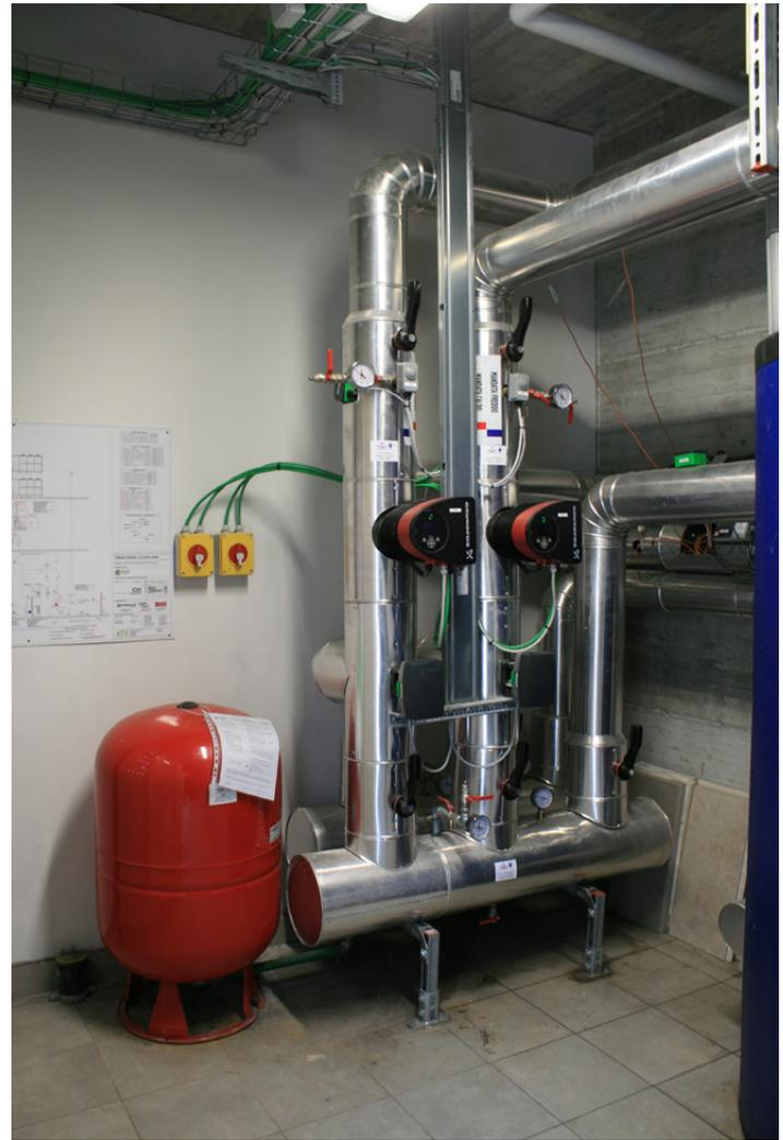
Semplice ed efficiente, l'impianto di climatizzazione prevede solo terminali radianti a pavimento in tutti i locali della scuola, con eventuale integrazione termica ad aria primaria
