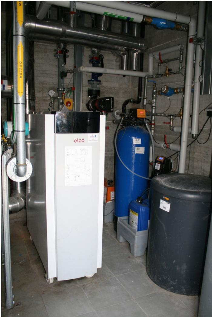
La caldaia a metano svolge funzione di backup completo rispetto alle pompe di calore e, quando necessario, contribuisce al contenimento dei consumi per riscaldamento e ACS
