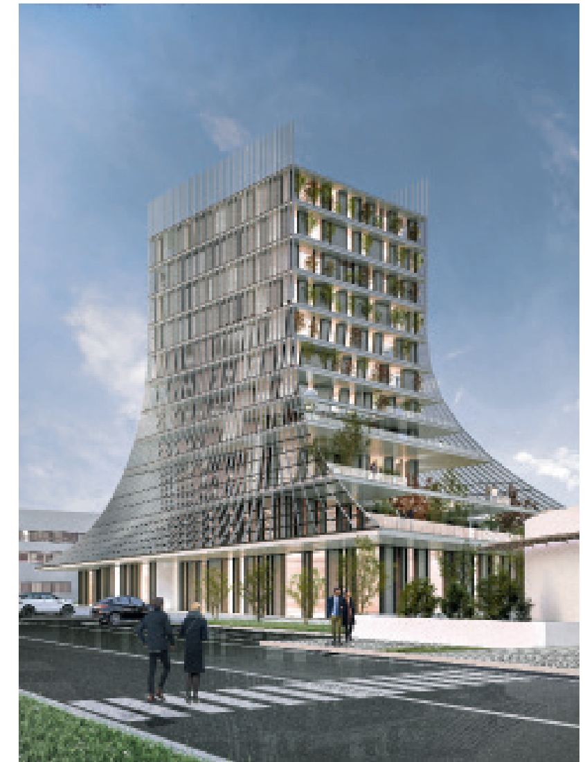
A nord e sud della Tower 3 Forti la vegetazione assume carattere architettonico, partecipando al disegno dei prospetti secondo le logiche della stagionalità delle essenze, mentre a est e ovest la rotazione dei piani diventa schermatura per la mitigazione dell'apporto solare e per l'individuazione degli accessi principali al progetto
