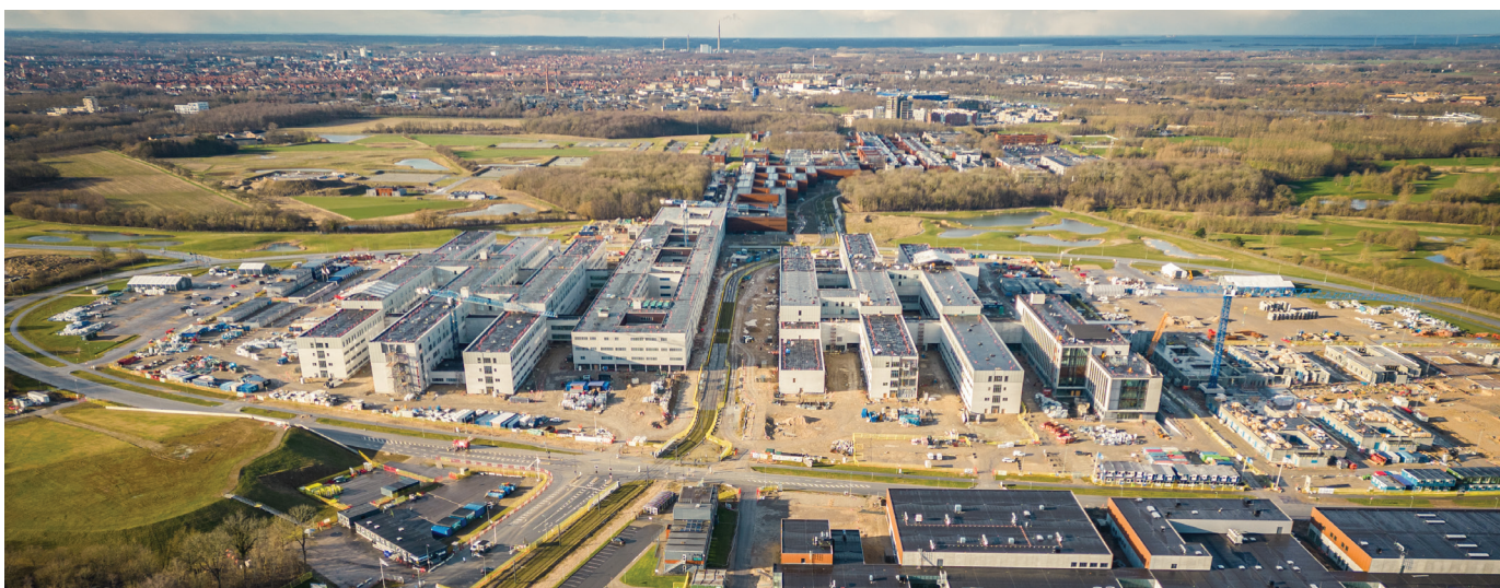
■ Cantiere del nuovo ospedale di Odense, aprile 2023
