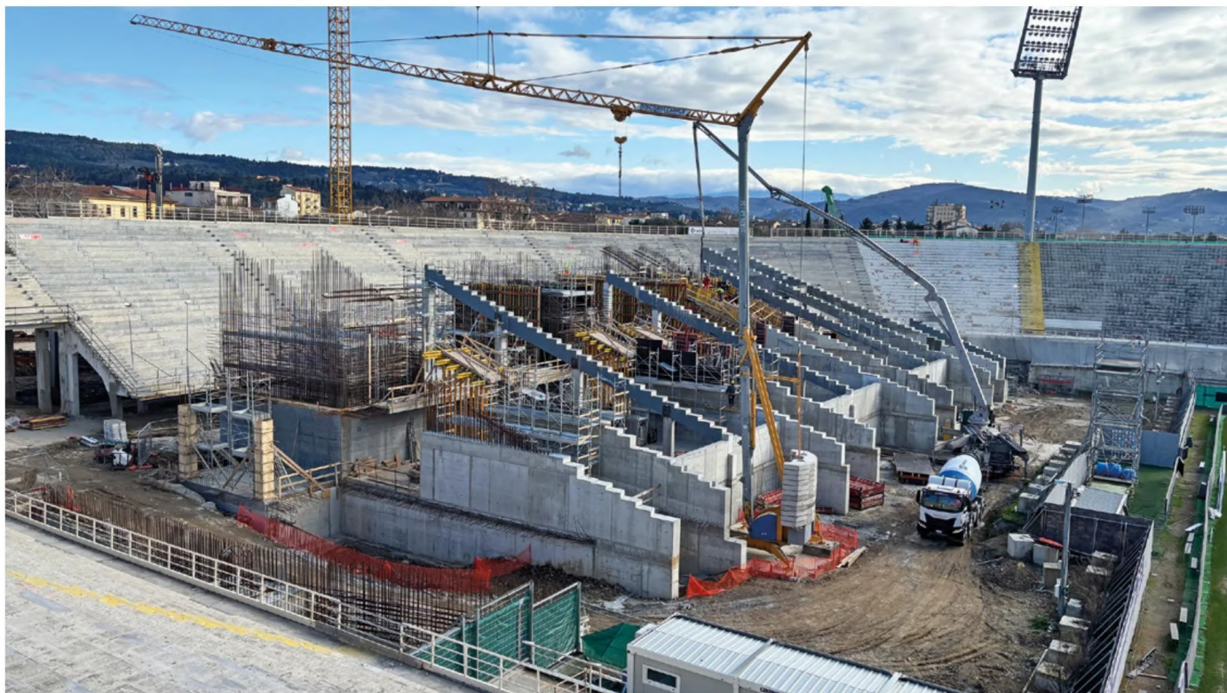
Lavori in corso allo stadio Artemio Franchi di Firenze.
