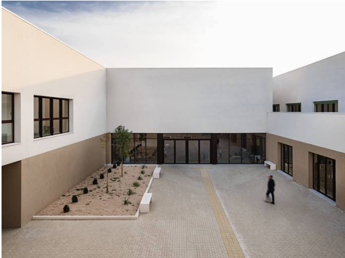
Patio. La nuova Scuola Secondaria di primo grado "P. Ingusci" a Nardò (LE). ATI Project. (ph Pierangelo Laterza)
